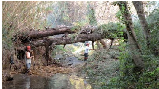
Travaux d'entretien de la rivière
