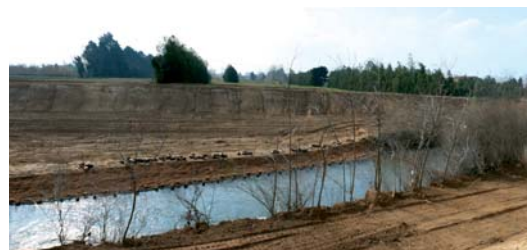
Travaux d'élargissement du lit du Coulon conduits par le SIRCC entre la route des Vignères et de celle de l'Isle-sur-la-Sorgue - Mars 2011
